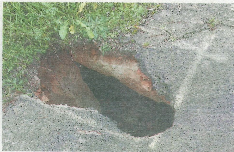
L'un des grès formant la voûte de l'ouvrage s'est écroulé laissant apparaître un trou sur le bord de la RD 34.
