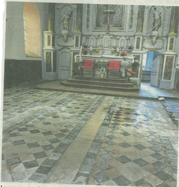
Le parquet a été retiré, laissant visible le carrelage.
