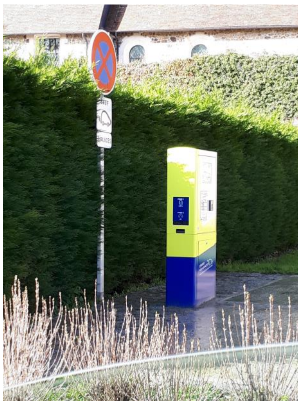
Photo 1. Aménagement de bornes électriques sur la commune déléguée d'Ajou
